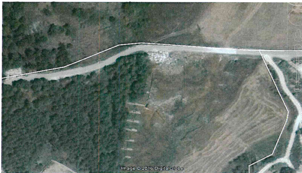
Prima dei lavori
