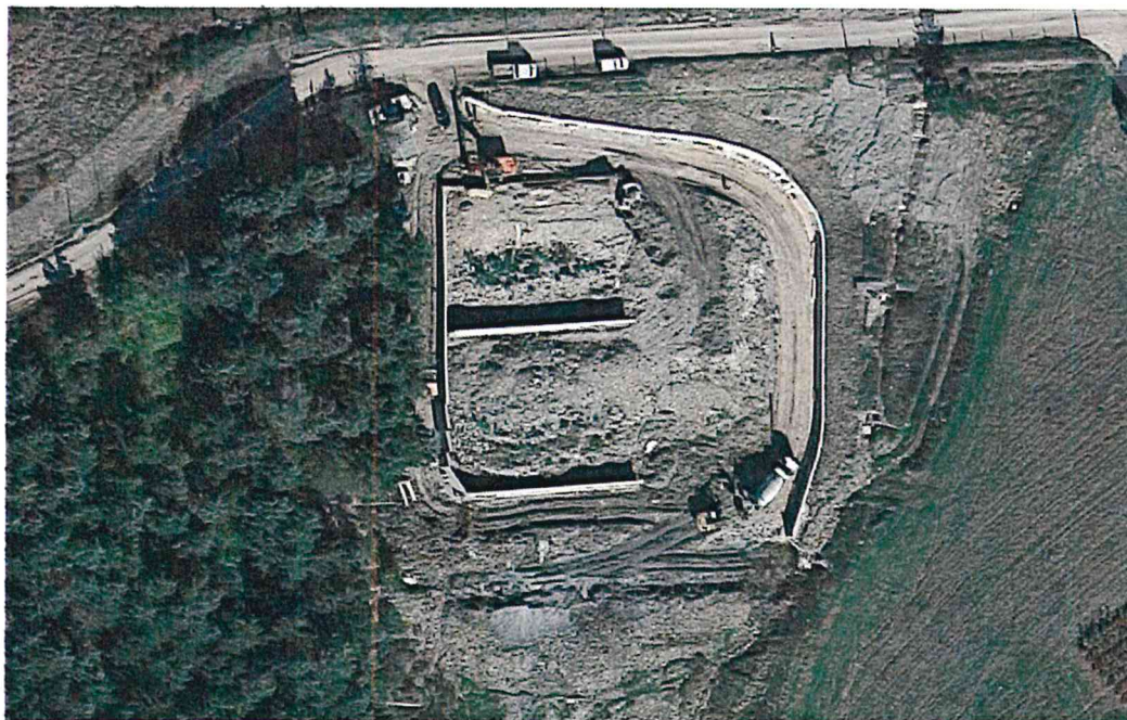
Durante i lavori
