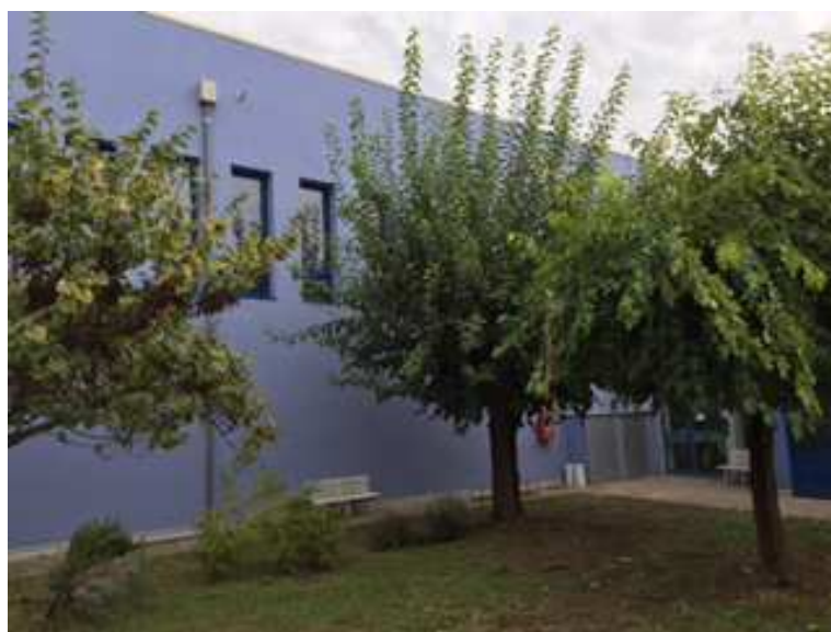
Foto 2. Esterno palestra riqualificata con cappotto, infissi e fotovoltaico sul tetto
