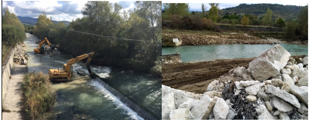
Demolizione della canalizzazione interna
