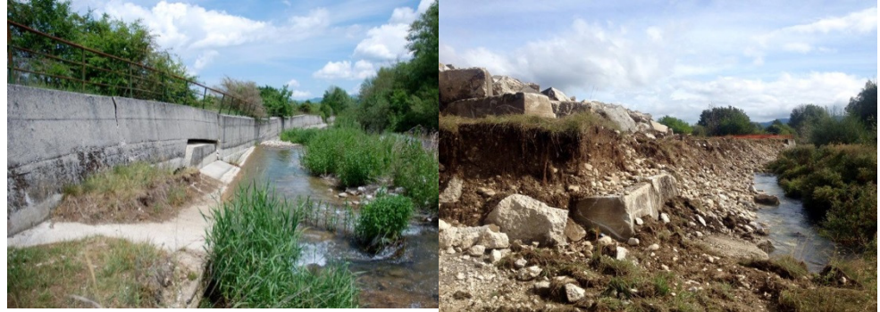
Demolizione del muro spondale esterno ammalorato (confronto prima e dopo intervento ancora in corso)
