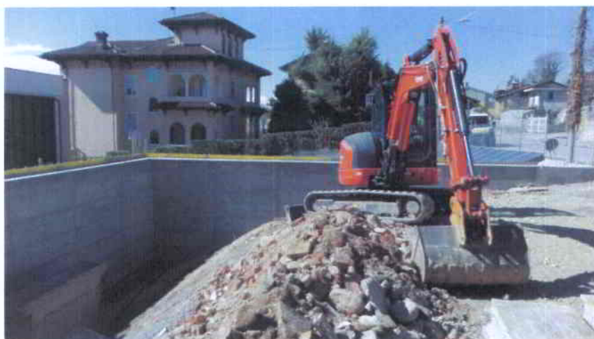
Costruzione di nuovo parcheggio Casa di riposo presso imp. Ftv esistente.
