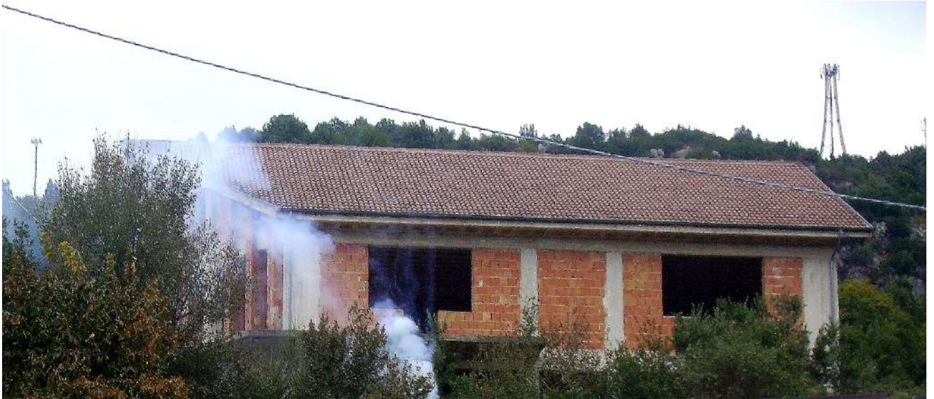
FOTO 1 - COM'ERA PRIMA DEI LAVORI
