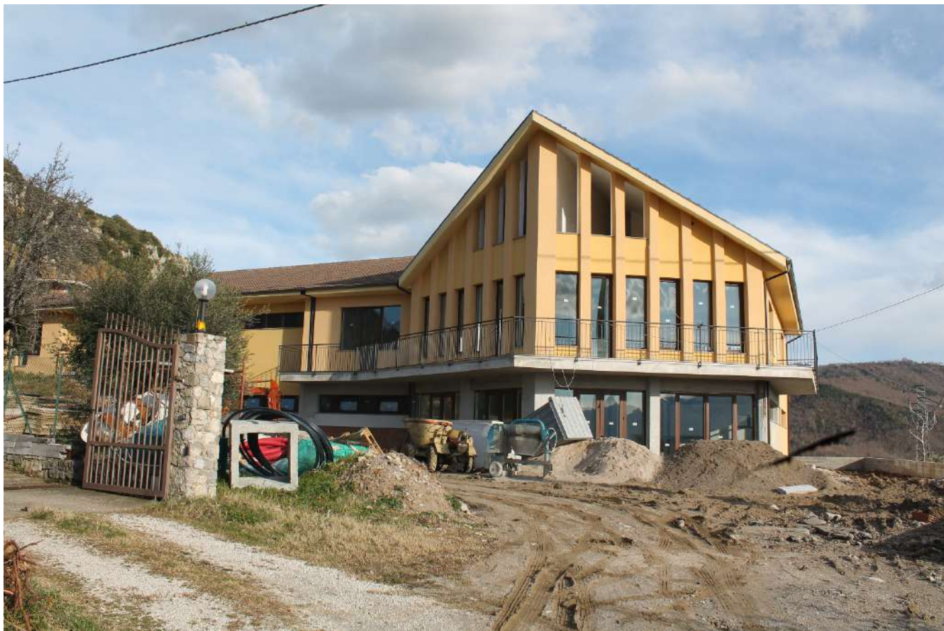
FOTO 3 – DURANTE I LAVORI
