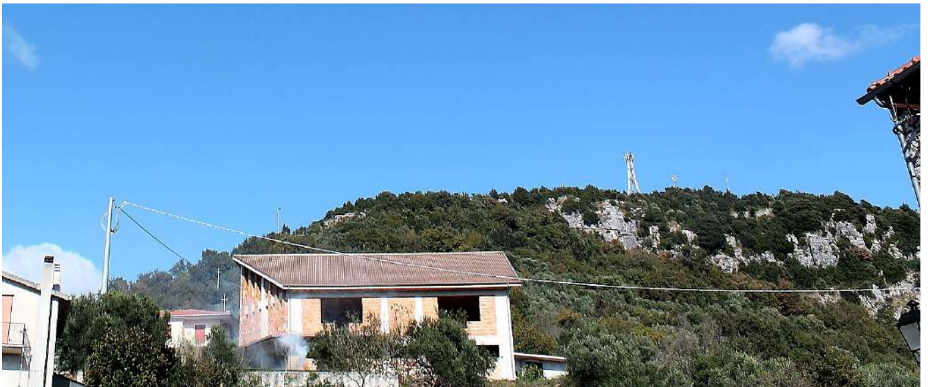
FOTO 2 - COM'ERA PRIMA DEI LAVORI
