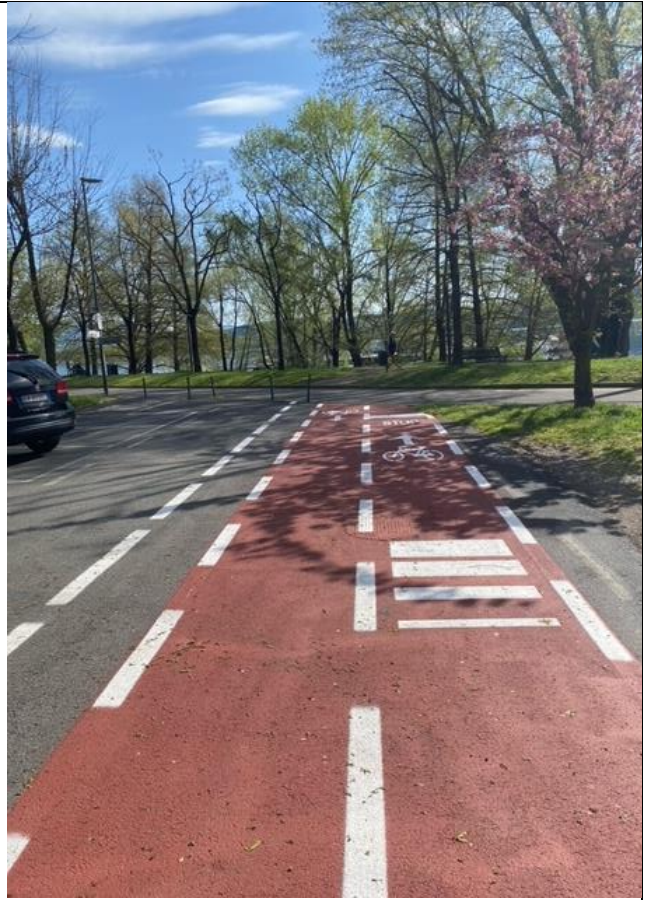
Foto 2 - Via Broggi – vista da via Broggi a corso Europa
