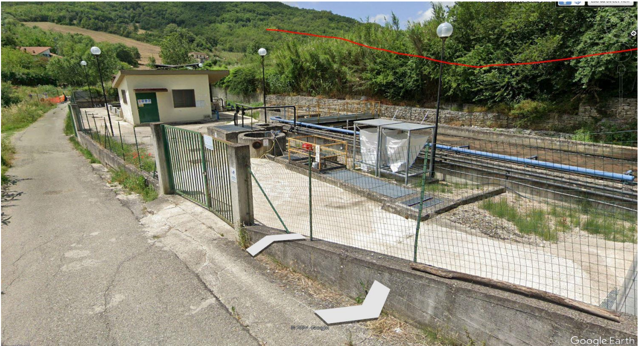
Fig. 26 (Depuratore di Via Piano dei Matti)
