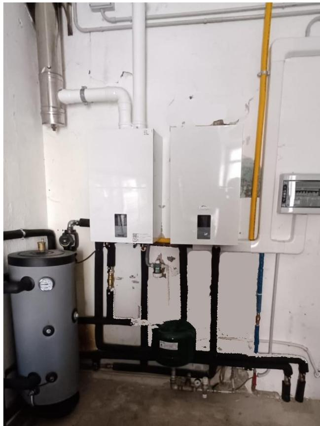
temperatura di alternanza, si disattiverà la pompa di calore ed entrerà in funzione solo la caldaia a metano, dal momento che al di sotto della temperatura di alternanza il coefficiente di prestazione COP della pompa di calore si abbatte drasticamente comportando la perdita dei benefici prodotti.
