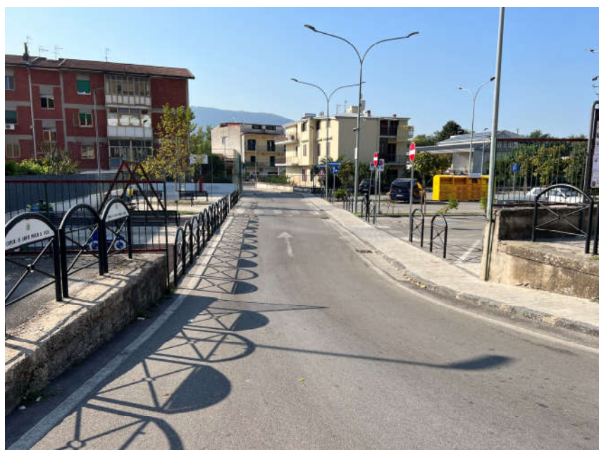
Strada di collegamento finalizzata a ridurre il traffico veicolare nel centro cittadino
