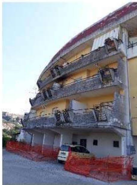
Tratto in curva sempre sul fronte nord nord-ovest
