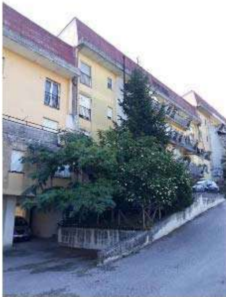
Salti di quota sul fronte nord-ovest
