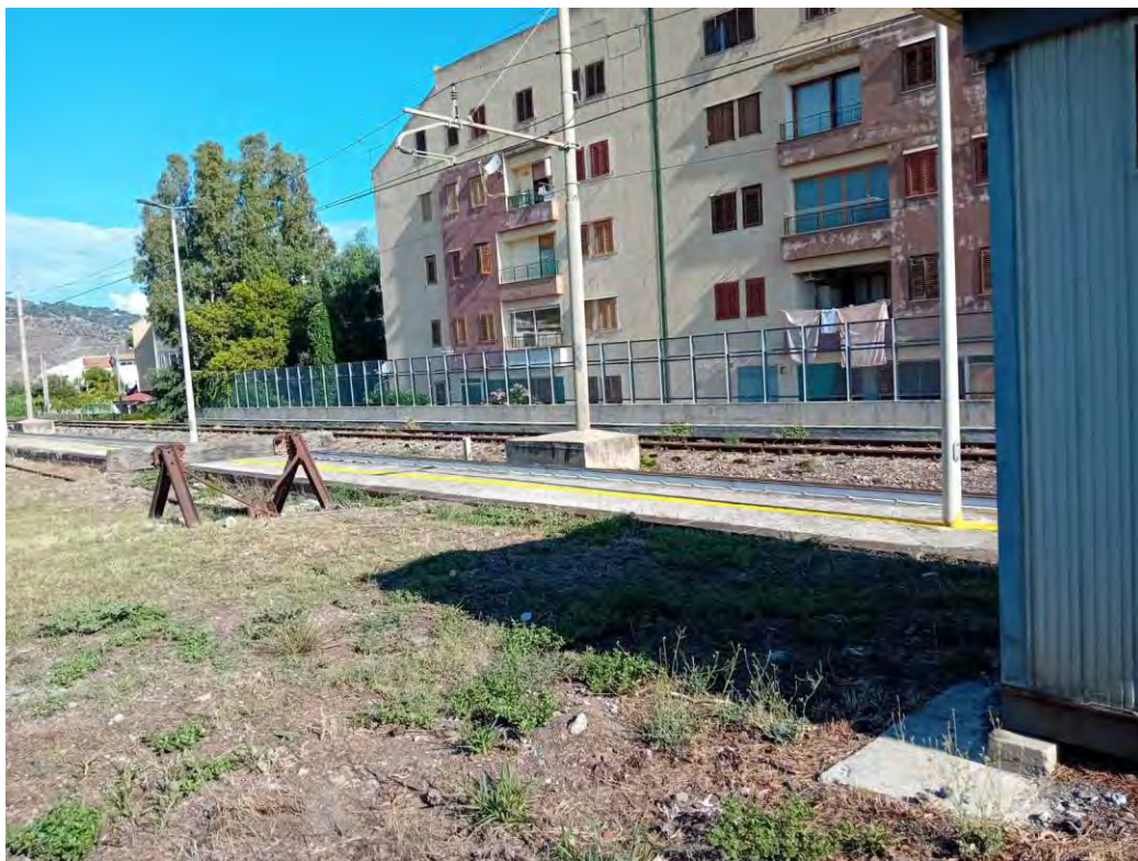
Fig 15_Vista verso i binari ferroviari
