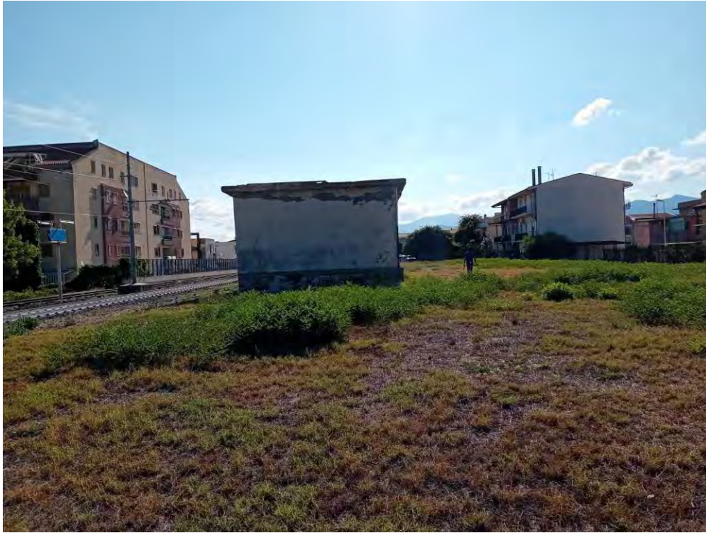
Fig 11_Vista edificio dismesso
