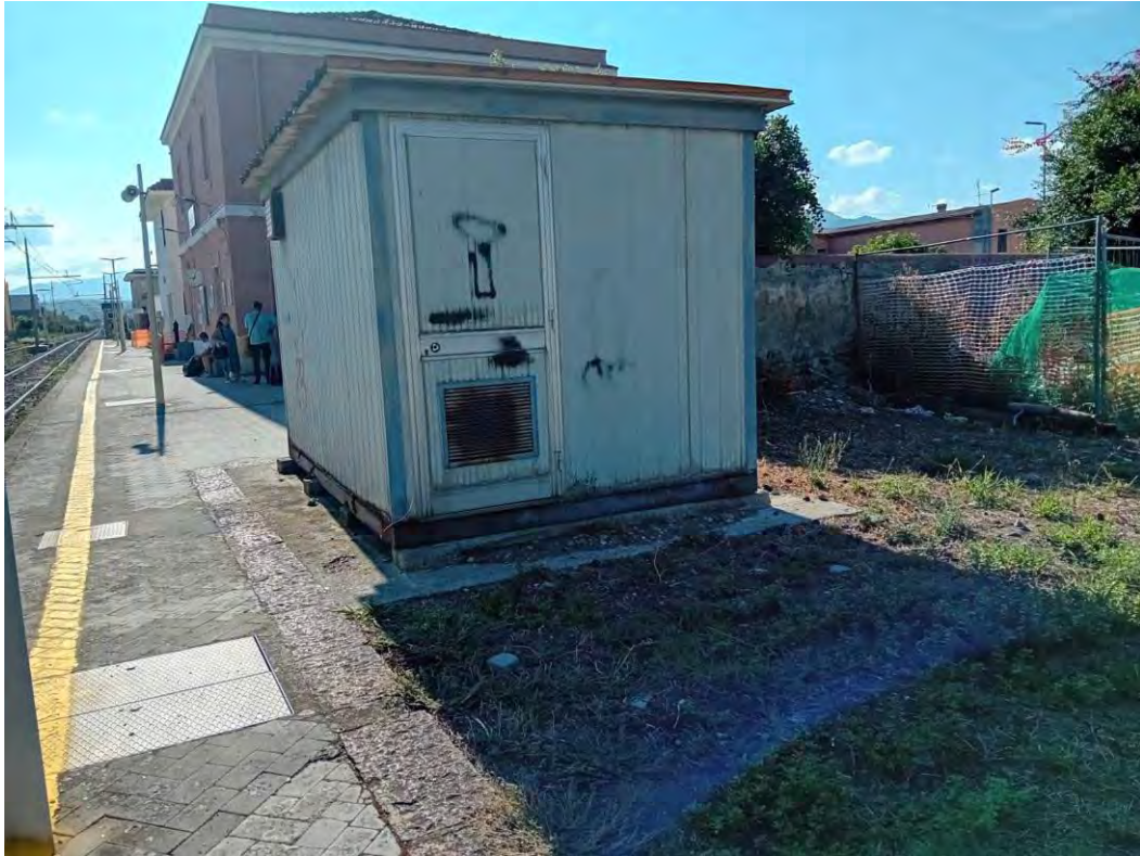
Fig 1_Vista dalla stazione ferroviaria di Falcone
