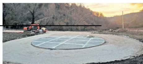
L'elisuperficie in fase di ultimazione e completamento a Longone Sabino
