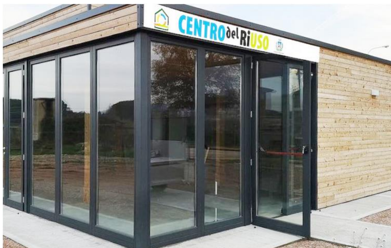
Realizzazione del Centro del Riuso, Voc. Pettinaro
