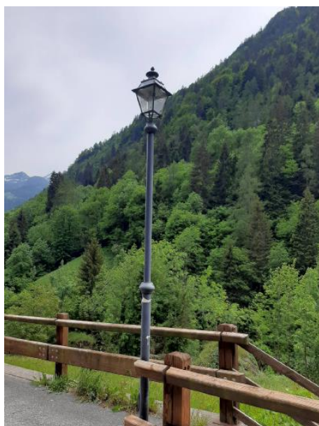
Gli apparecchi in cui sono stati sostituite le lampade.
