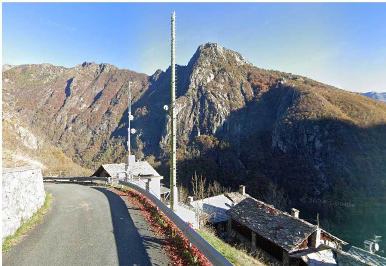
Immagine dell'intervento concluso.
