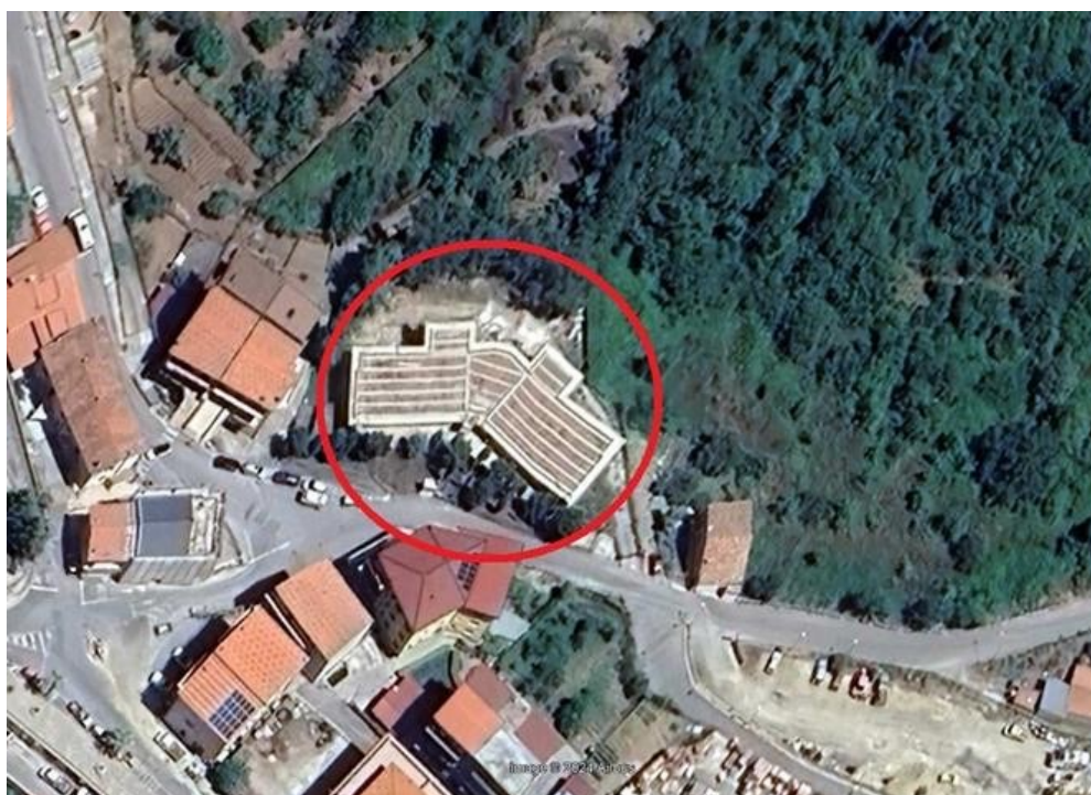
Figura 5- Copertura della scuola
