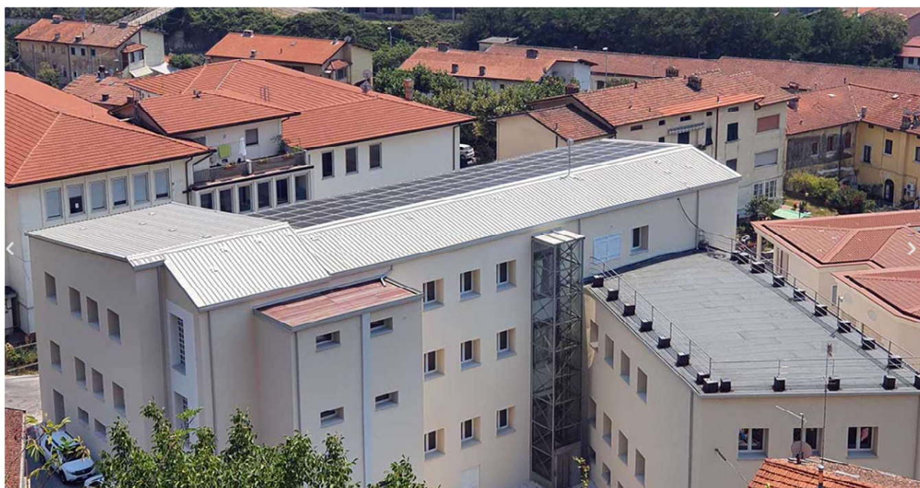
Fig. 12 - Immagine del Municipio di Seravezza dopo l'intervento di efficientamento – parte retrostante e copertura
