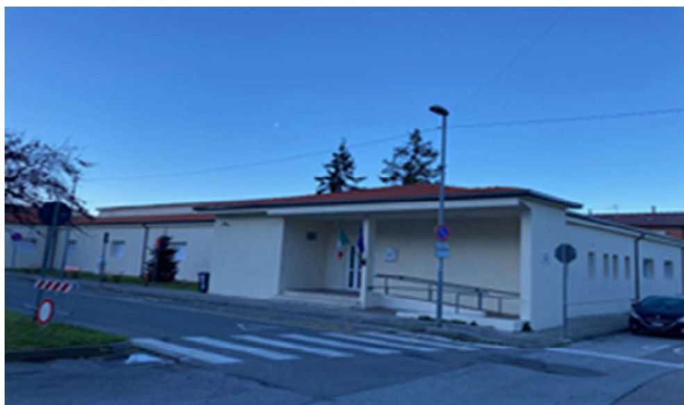
Fig. 15- Immagine attuale della Scuola Italo Calvino dopo l'intervento di efficientamento
