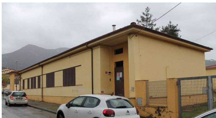
Fig. 14- Immagine dell'area lato Massa della Scuola Italo Calvino prima l'intervento di efficientamento
